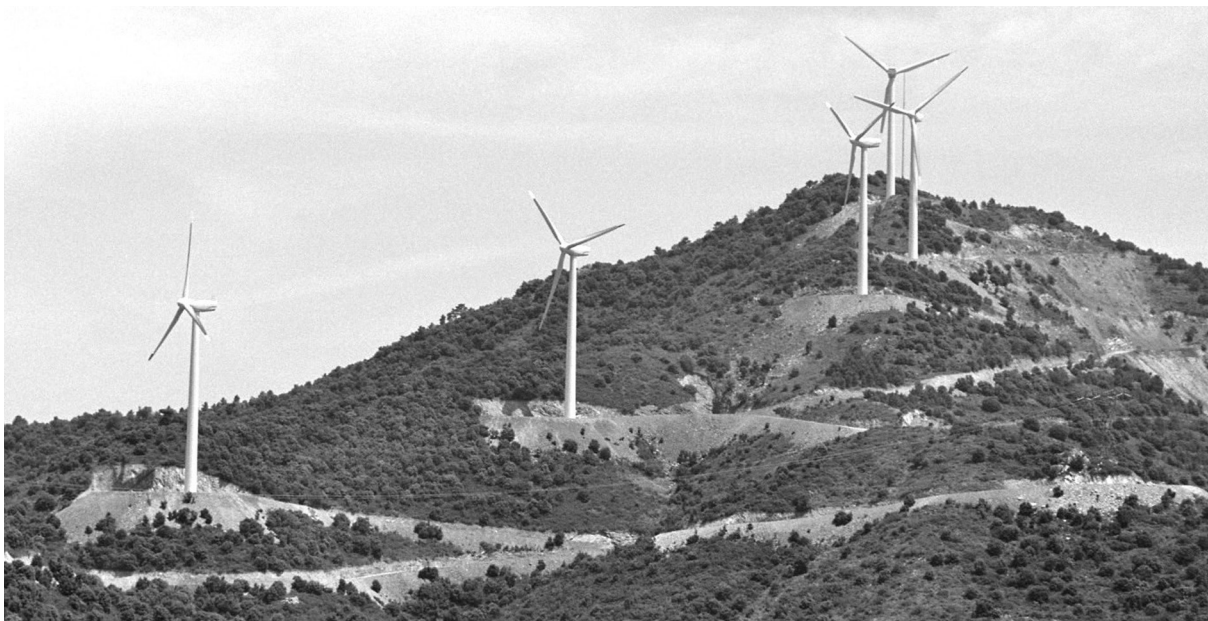
Detall de la central eòlica del Collet dels Feixos, als municipis de Riudecols i Duesaigües (Baix Camp), i prop del Coll de la Teixeta, al límit de la comarca del Priorat. Poden apreciar-se els desmunts i talussos de les plataformes dels aerogeneradors i dels camins d'accés, particularment a la dreta de la imatge. (Foto: Tarroja)
